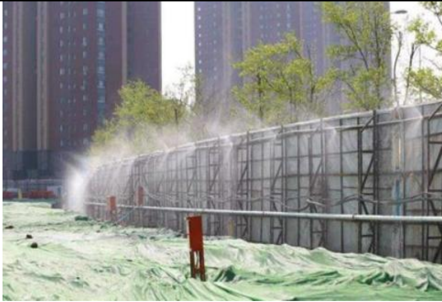
图 4-3 喷淋系统示意图
